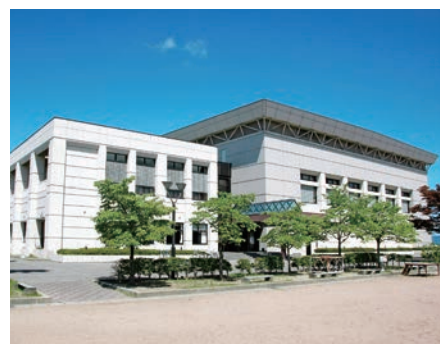
天童市／スポーツセンター総合体育館
